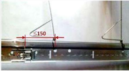
*Рис. 26. Дополнительный подвес около стыка несущих реек*
