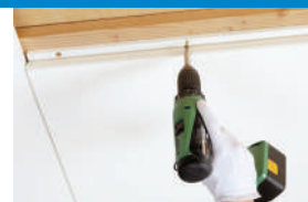
Монтаж Master F с помощью саморезов
